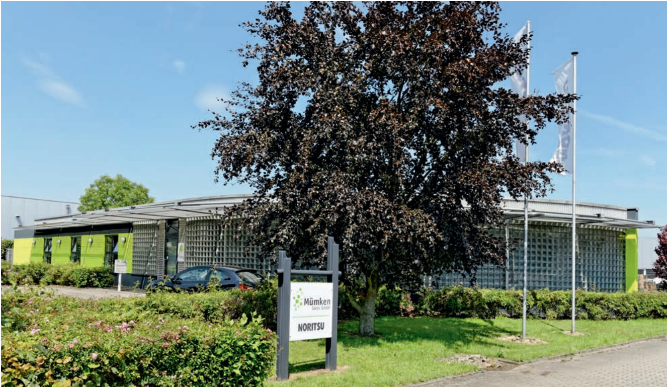
► Frontansicht des 450 m 2 großen Verwaltungstraktes der Mümken Sales GmbH im Hünxer Gewerbegebiet Bucholtswelmen-Ost.
