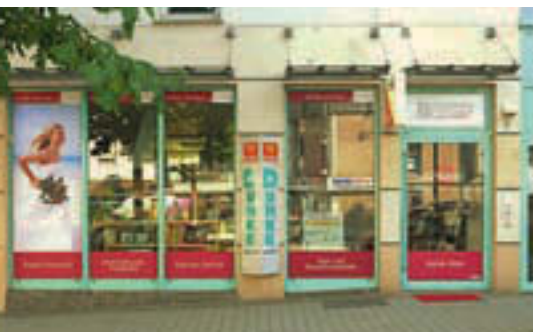
Schon außen ein Hingucker: die seit Juni 2008 neugestaltete Ladenfront.
